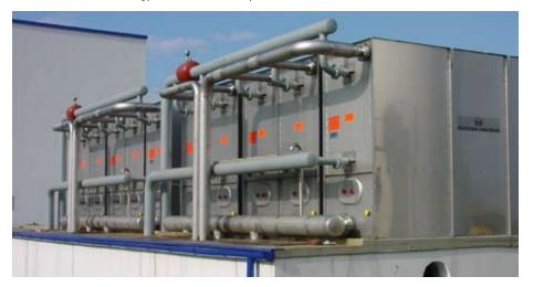
Druckbelüftet mit Radialventilatoren: Bessere akustische Dämpfungsmöglichkeiten, geringere Bauhöhe, einfache Wartung, Installation im Gebäude möglich. Saugbelüftet mit Axialventilatoren: Geringerer Energiebedarf, geringere Aufstellfläche.
