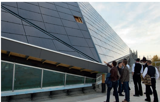
Blick auf einen Teil der PV-Anlage anlässlich des Aufrichtfestes Ende Oktober 2011. Besucher bestaunen die imposante Anlage. (Bild: Umwelt Arena)
