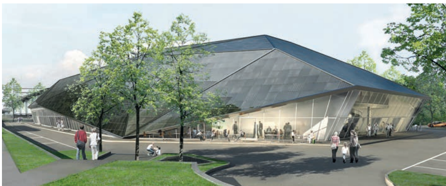
Auf dem Dach der Umwelt Arena entsteht mit einer Gesamtleistung von 750 kWp die grösste dachintegrierte Solaranlage der Schweiz. (Visualisierung: raumgleiter)
