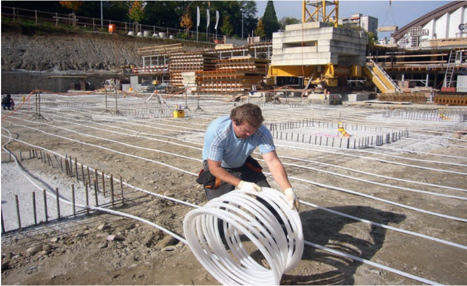
Erdkollektoren werden fachgerecht verlegt. Sie bilden eine wichtige Stütze einer innovativen Energieversorgungslösung.
