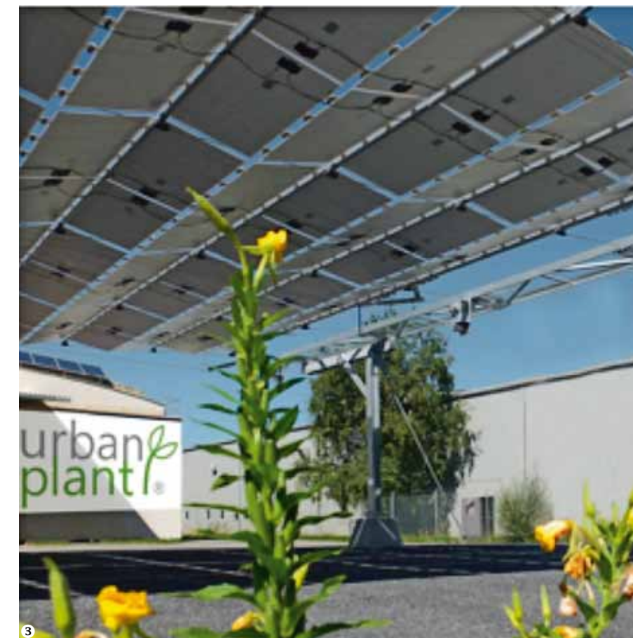
Urban plant: Die einziehbaren PV-Module sind nicht der Witterung ausgesetzt.
