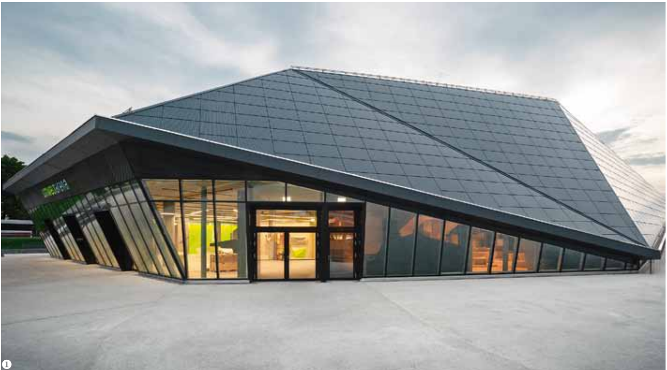
Passgenaue c-Si-Module, Umwelt-Arena Spreitenbach (System Megaslate, Meyer Burger, Thun).
