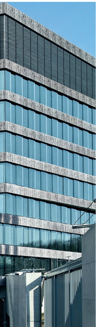
Der neue Uetlihof setzt die vor 40 Jahren realisierte Bürolandschaft der Credit Suisse am Fusse des Üetlibergs in Zürich fort und vereint höchste Standards zur Optimierung des Energieverbrauchs. Fotos Credit Suisse AG
