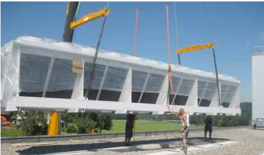
Exakt wird ein Rückkühler auf die Fundamente abgesetzt.
